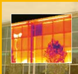
Inspección térmica de la instalación de una ventana.
