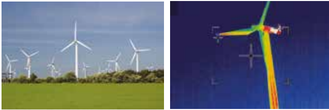
Termografía de una turbina eólica tomada desde el suelo.
